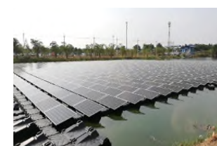
พลังงานแสงอาทิตย์ ติดตั้งบนทุ่นลอยน้ำ
