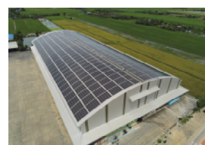
พลังงานแสงอาทิตย์ ติดตั้งบนหลังคา
